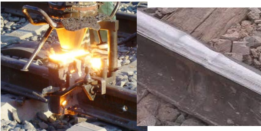
Soldadura Aluminotérmica (TW)
