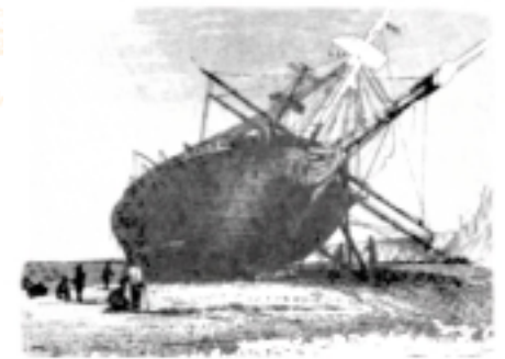
Reparación del Beagle a orillas del río Santa Cruz.
